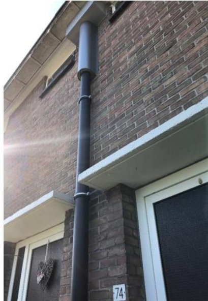
Door middel van een isolerende beschermingskap wordt het koppelpunt afgedekt.
